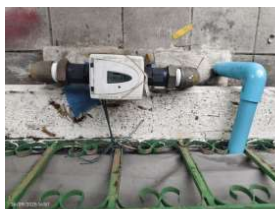
รูปที่ 2-40 แสดงการติดตั้งมิเตอร์รับน้ำและระบบท่อประปาเชื่อมต่อกับท่อประปาของสำนักงานประปานครหลวง
