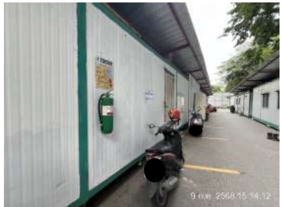
รูปที่ 2-63 แสดงถังดับเพลิงชนิดผงเคมีแห้ง พร้อมป้ายแนะนำการใช้งาน
