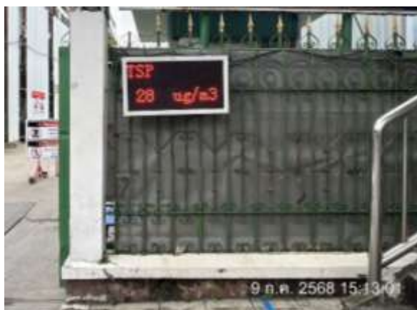
รูปที่ 2-29 แสดงการติดตั้งระบบตรวจสอบค่าความเข้มข้นของ TSP PM 2.5 PM 10 และระดับเสียง แบบการประมวลผลทันที (Real time) ผ่านหน้าจอแสดงผลไว้ด้านหน้าโครงการ
