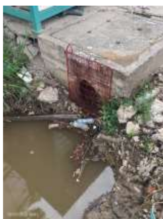
รูปที่ 2-66 แสดงตะแกรงดักมูลฝอยในบ่อพักน้ำสุดท้าย
