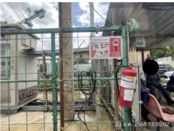
รูปที่ 2-63 แสดงถังดับเพลิงชนิดผงเคมีแห้ง พร้อมป้ายแนะนำการใช้งาน
