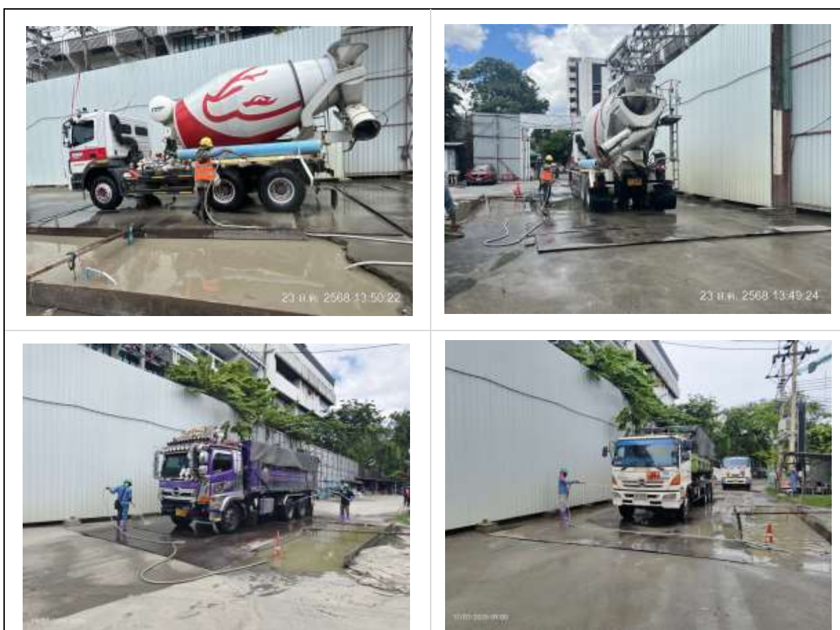
รูปที่ 2-21 แสดงเจ้าหน้าที่ทำความสะอาดล้อรถบรรทุก
