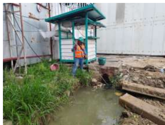
รูปที่ 2-38 แสดงเจ้าหน้าที่ทำความสะอาดที่ระบายน้ำ และบ่อดักตะกอนของโครงการ
