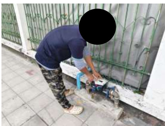
รูปที่ 2-40 แสดงการติดตั้งมิเตอร์รับน้ำและระบบท่อประปาเชื่อมต่อกับท่อประปาของสำนักงานประปานครหลวง
